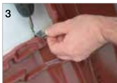
3 van bovenaf in de panlat schroeven.
