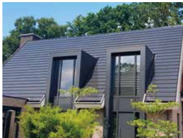
G 10 S PV energiedak
