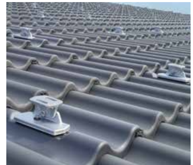
PV-draagpannen voor het aanbrengen van opdak zonnepanelen.
