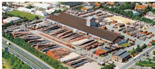
Fabriek Dieburg (Betonpannen)
