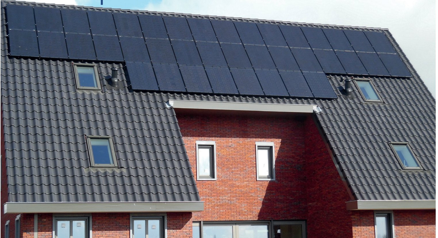
△ PVT-panels wekken zowel stroom als zonnewarmte op.
