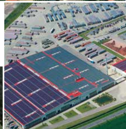
Fabriek Nibra Groß-Ammensleben (keramische pannen)
