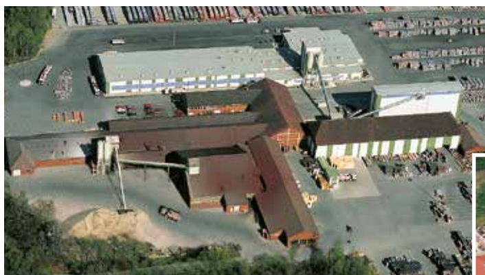
Fabriek Schermbeck-Gartrop (betonpannen)
